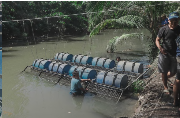
Gambar 7. Pemasangan Trash Trap
