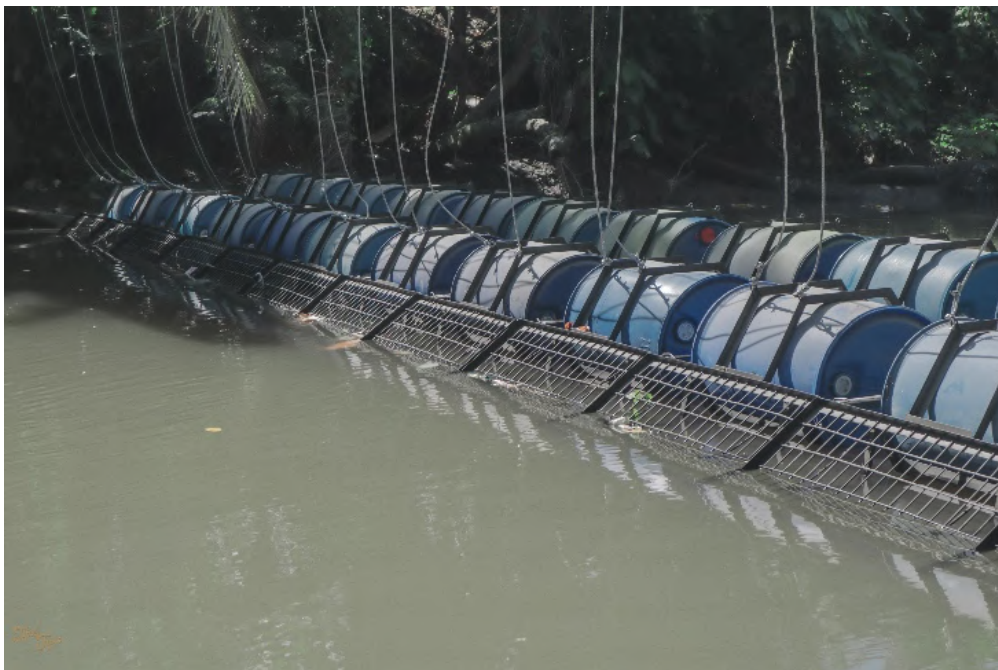
Gambar 8. Trash Trap telah terpasang sempurna
