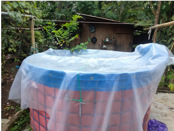
Gambar 2. Pembangunan Kolam Bundar di Desa Sokong, Lombok Utara
