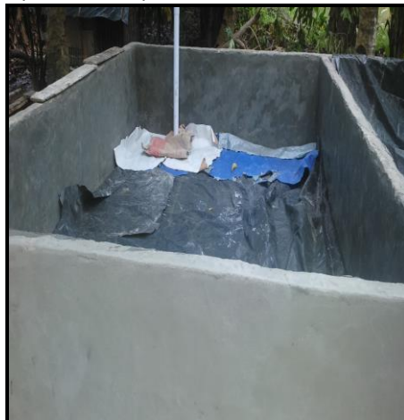
Gambar 3. Pembangunan Kolam Budidaya
