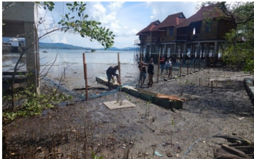
Gambar 6. Pemasangan jaring pelindung
