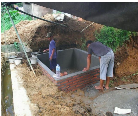
Gambar 3. Pembuatan biogas di Nyatnyono
