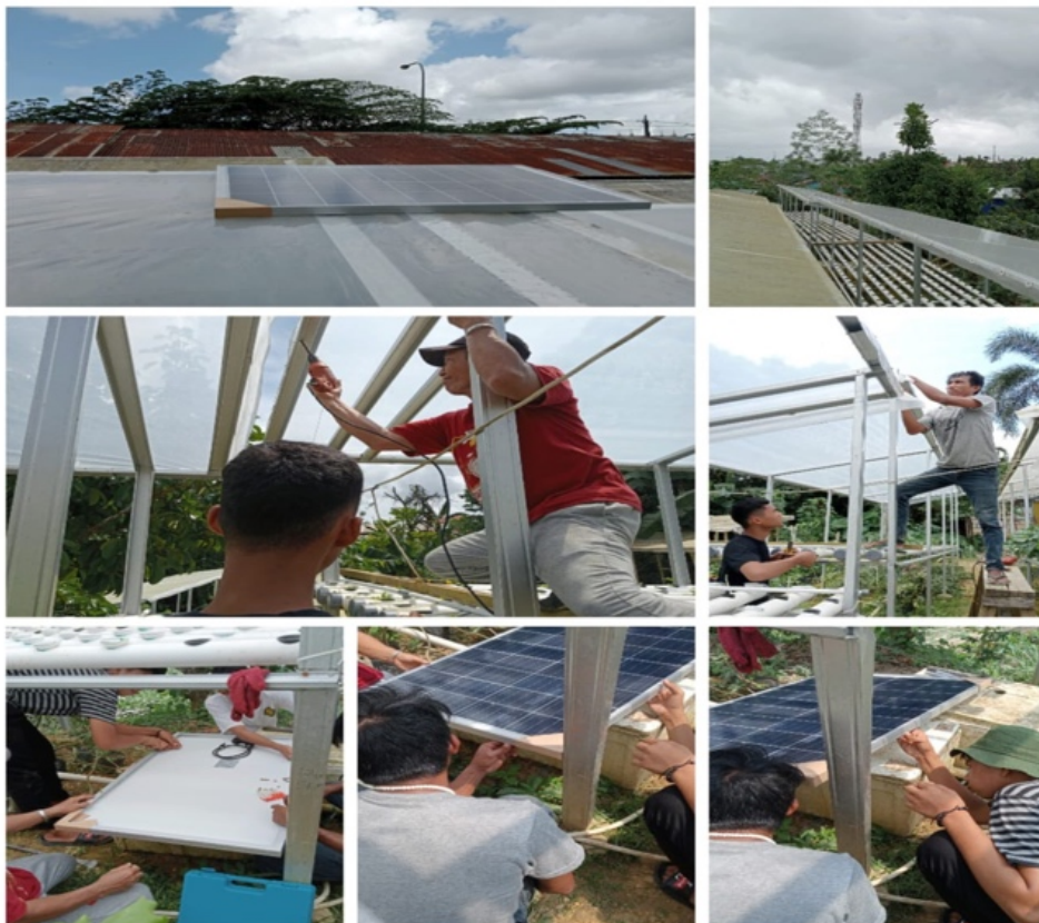
Gambar 6. Pemasangan sistem pembangkit listrik tenaga surya untuk tanaman hidroponik pada usaha Nuri Holti Hidro
