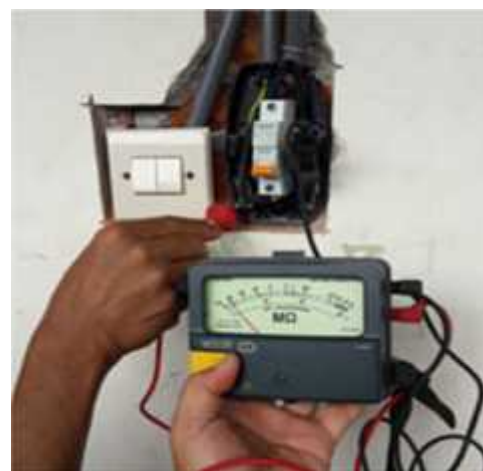
Gambar 7. Pengukuran kualitas instalasi yang telah dipasang
