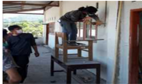
Gambar 6. Praktek pemasangan instalasi listrik di madrasah at-attahzib
