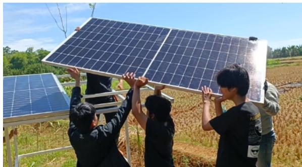
Gambar 6. pemasangan panel surya pada dudukannya
