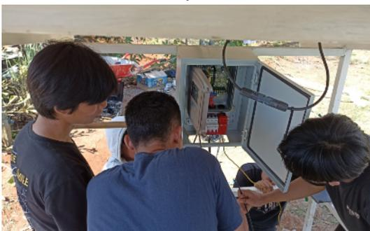
Gambar 7. instalasi kontroler pompa
