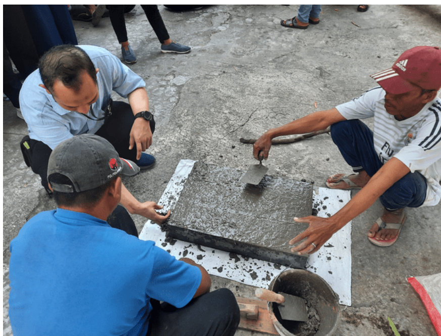
Gambar 5. Pembuatan deker saluran
