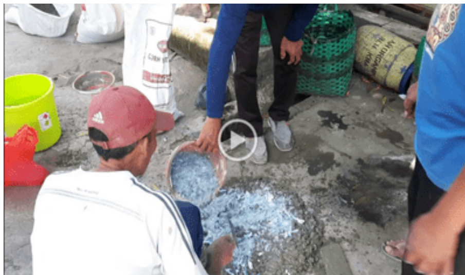
Gambar 4. Campuran limbah sebagai bahan tambah deker saluran
