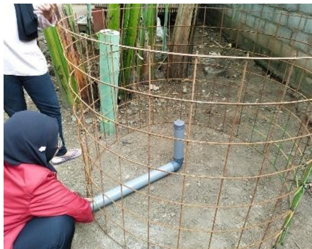
Gambar 5. Pemasangan pipa outlet kolam bundar
