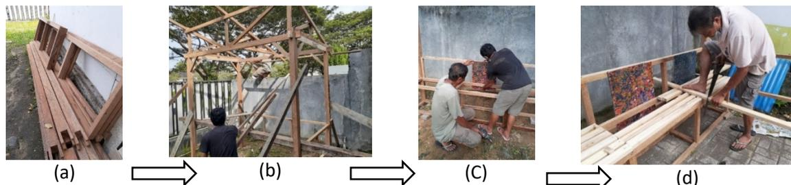
Gambar 8. Pekerjaan konstruksi shelter (a) Penyediaan material kelapa (b) Konstruksi shelter dari kayu kelapa (c) Pemasangan panel komposit (d) Kelengkapan shelter yaitu tempat duduk
