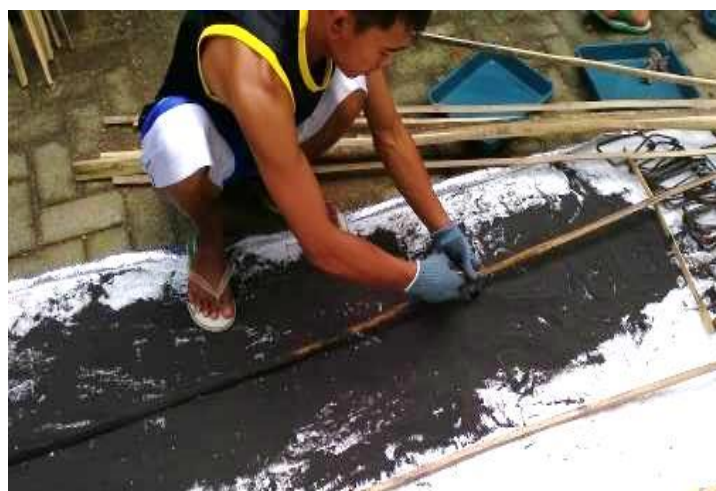
Gambar 5. Pelaburan pasir pada tulangan bambu
