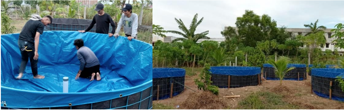
Gambar 6. Terpal dan wiremesh pada bak bundar bioflok siap digunakan.
