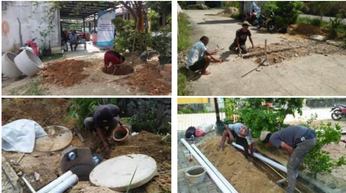
Gambar 7. Pelaksanaan pemasangan prototipe sumur resapan
