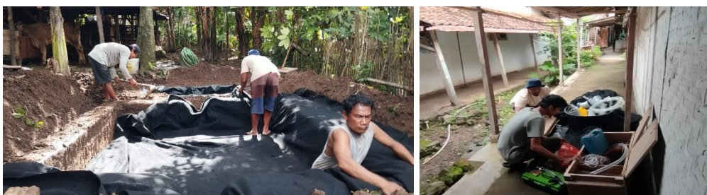
Gambar 3. Proses Instalasi Biogas Geomembrane oleh Tim dan Masyarakat
