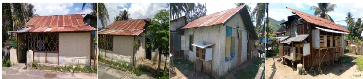
Gambar 3. Peserta Belajar Cara Mendokumentasikan 4 Tampak Sisi Bangunan Rumah
