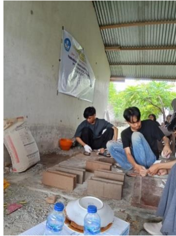
Gambar 3. Pelatihan Teknik Pencampuran dan pencetakan batako ringan hari ke-2
