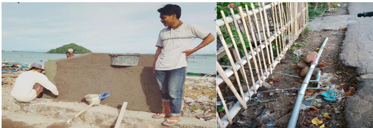
Gambar 4 Pembuatan tempat penampungan dan pipanisasi penyaluran air tawar.
