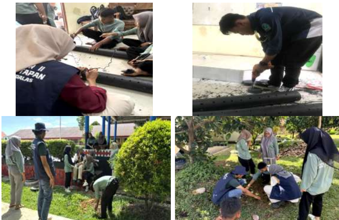
Gambar 4. Proses pembuatan dan pemasangan lubang resapan biopori
