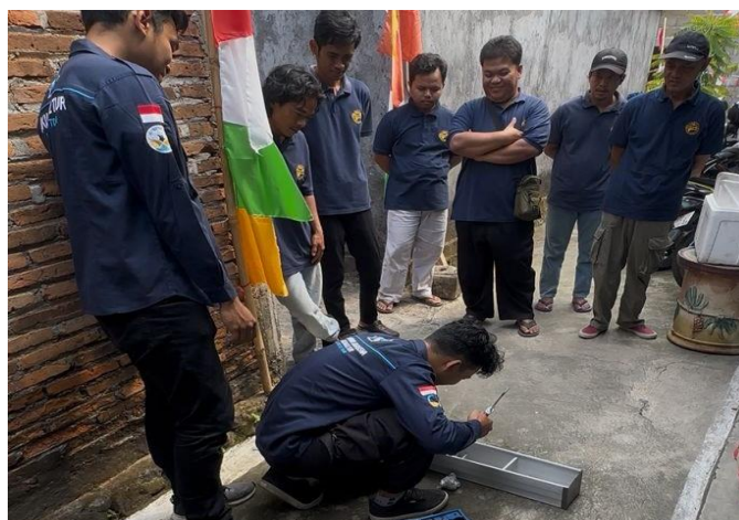
Gambar 4. Pembuatan Talang Filtrasi PVC
