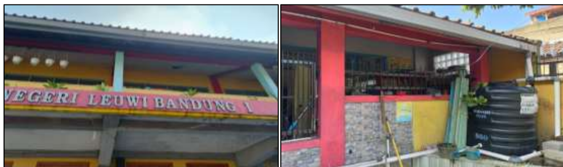
Gambar 5. Pemasangan talang pada atap dan instalasi pemanenan air hujan.
