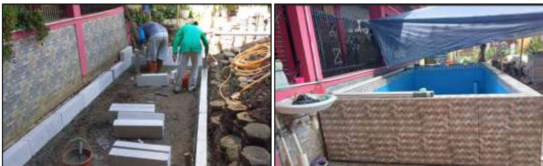
Gambar 6. Proses pembuatan kolam ikan permanen sistem RAS.
