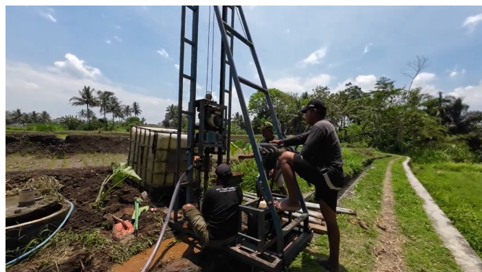
Gambar 4. Pembuatan Sumur Bor Kedalaman 20 m Sebagai Sumber Air Bersih
