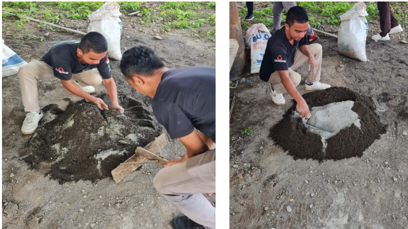
Gambar 5. Proses pencampuran material untuk pembuatan batako
