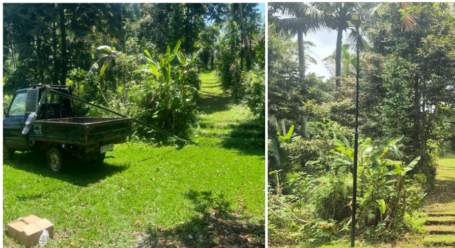
Gambar 2. Pemasangan Penerangan Panel Surya
