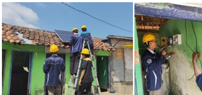
Gambar 5. Dokumentasi proses pemasangan panel surya di atap kamar mandi
