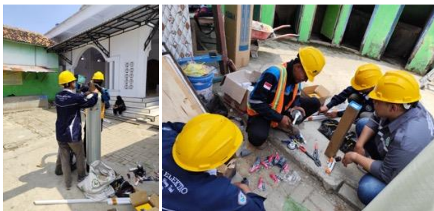
Gambar 6. Pompa air dan tandon setelah selesai diinstalasi
