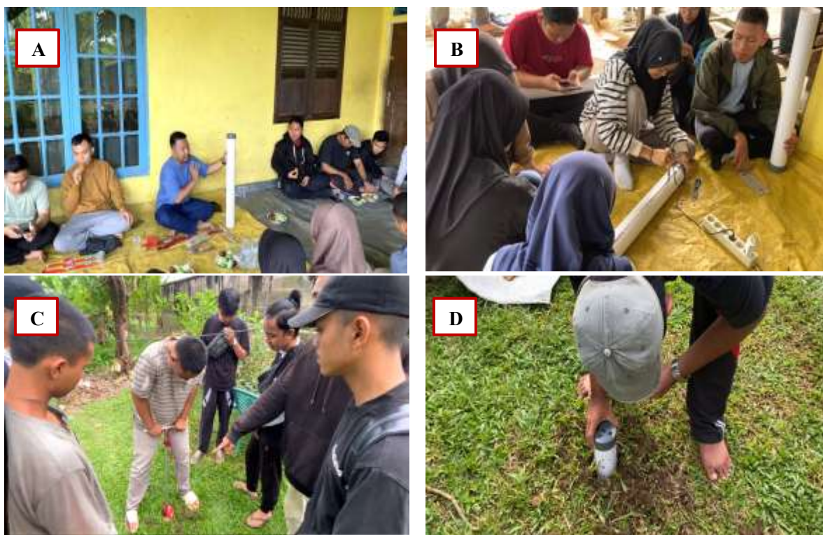
Gambar 4. Pelatihan dan penerapan teknologi Lubang Resapan Biopori (LRB) : a) Penjelasan teknis pembuatan LRB; b) Persiapan pipa PVC dilakukan dengan melubanginya menggunakan solder; c) Pembuatan lubang di tanah menggunakan bor biopori hingga kedalaman sekitar 100 cm; d) Pemasangan pipa PVC yang telah dilubangi pada tanah
