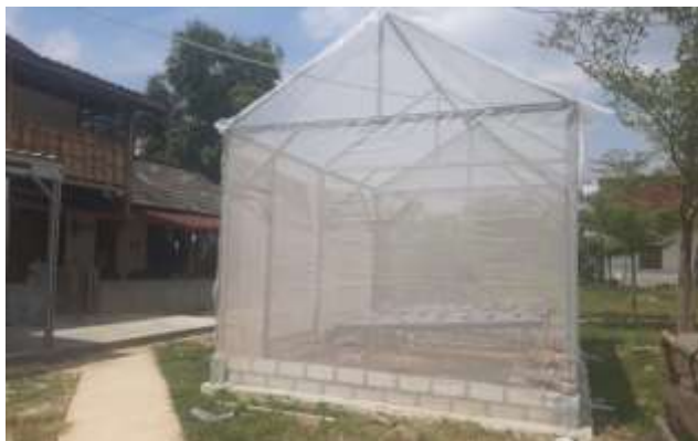
Gambar 4. Bangunan Greenhouse dengan Rangka Hollow, Atap UV dan Dinding Insect Net
