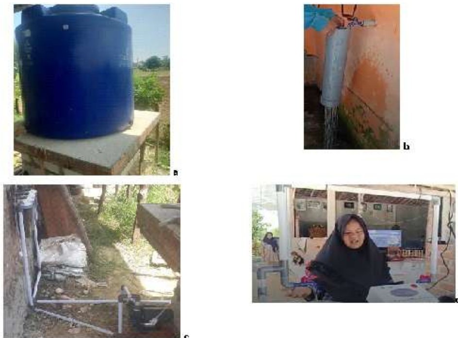
Gambar 6. Dokumentasi Sistem IPAH (a) toren penampung air hujan; (b) pencucian filter berupa pasir silika, pasir mangan, dan karbon aktif; (c) pompa air dan housing filter; (d) lampu UV dan air bersih
