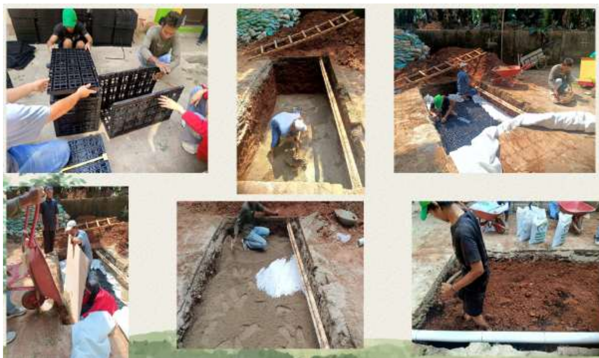
Gambar 5. Proses Pembuatan Drainase
