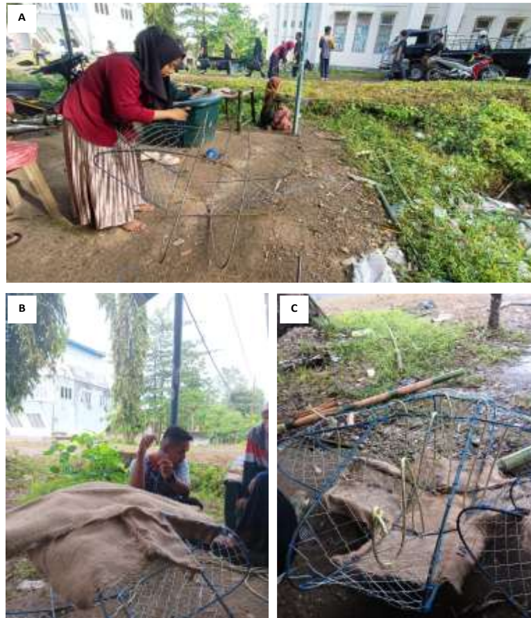
Gambar 4. A. Penjahitan kawat harmoni, B. Penjahitan karung goni, C. Pemasangan tali rami.
