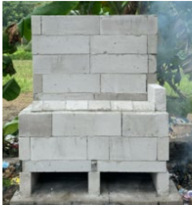
Gambar 3. Proses pembuatan bak sampah
