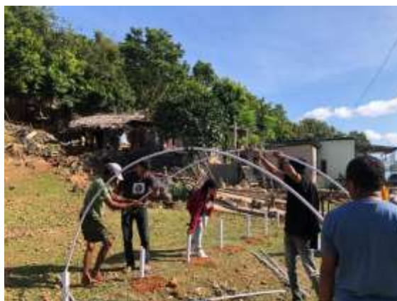
Gambar 3. Pembuatan rangka rumah pengeringan rumput laut
