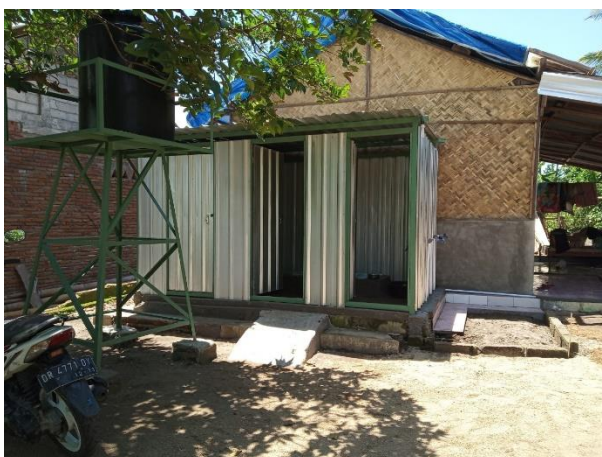
Gambar 4. Set fasilitas sanitasi
