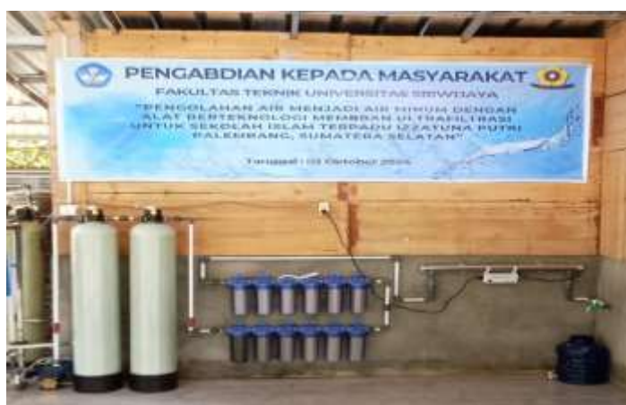
Gambar 3. Rangkaian alat pengolahan air berteknologi membran ultrafiltrasi
