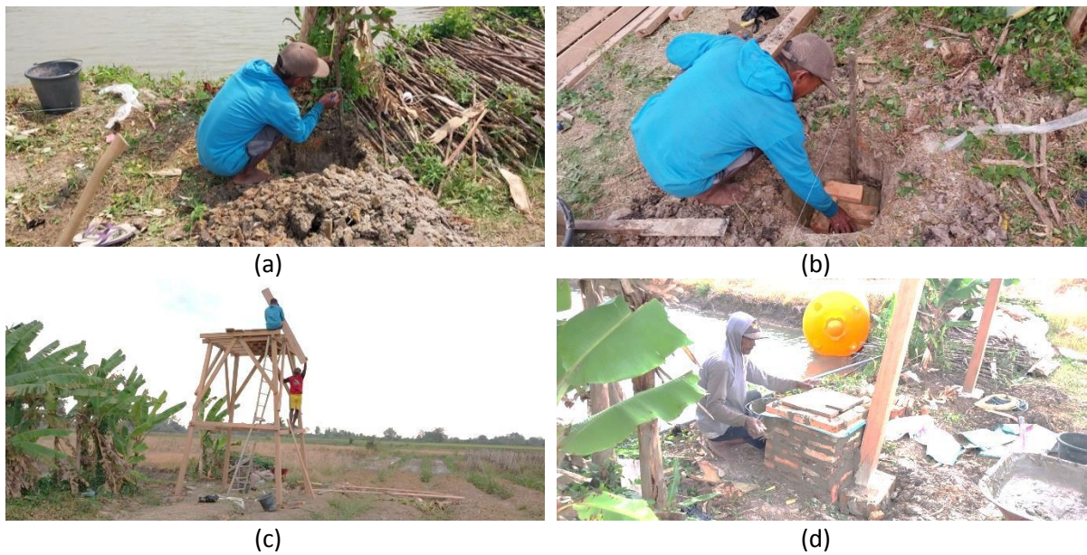
Gambar 3. (a) Pengukuran area pondasi tower, (b) Pengecoran pondasi kaki tower, (c) Perakitan tower, (d) Pembuatan rumah pompa.
