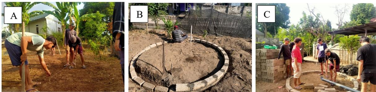
Gambar 2. Persiapan Pembuatan Kolam. A ) Pengukuran diameter, B) Penyusunan Batako, D) Memasang Pipa Pembuangan
