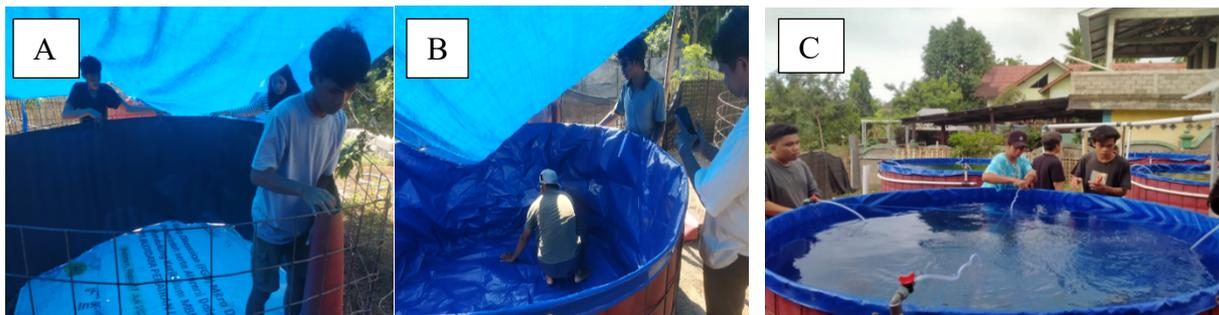
Gambar 4. Pemasangan Terpal dan Aerasi. A) Pelindung Terpal, B) Pemasangan Terpal, C) Pemasangan Selang Aerasi.
