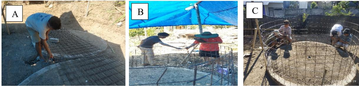
Gambar 3. Pemasangan Rangka Kolam. A) Merapikan sisi wiremesh, B) Membentuk wiremesh menjadi rangka berbentuk lingkaran, C) Menyambung ujung wiremesh.
