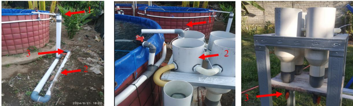
Gambar 5. Pengendapan. 1) Air Water Lift (AWL), 2) Tempat Pengendapan, 3) Katup Pembuangan Endapan
