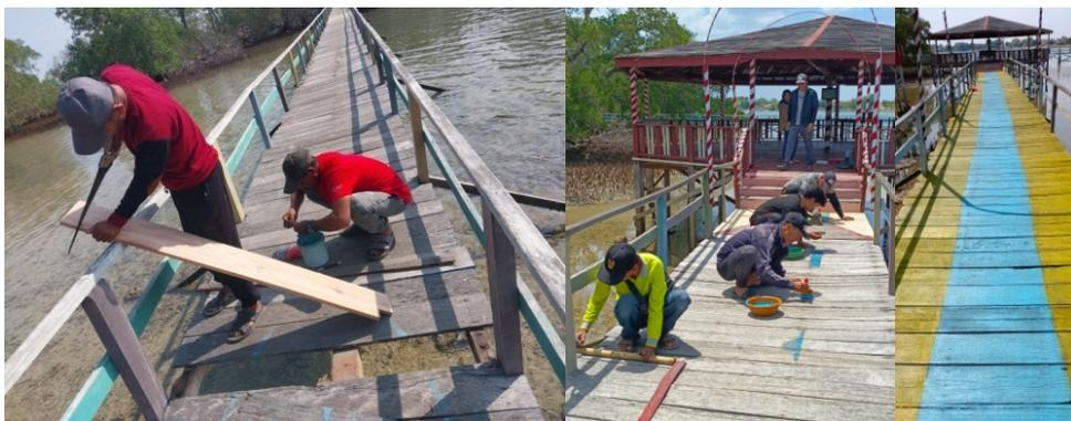
Gambar 10. Penggantian Papan Dan Pengecatan Ulang Jalur *Tracking* Mangrove
