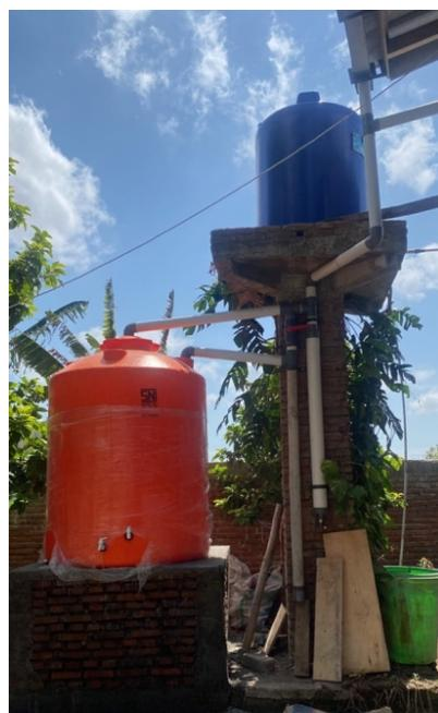
Gambar 3. Sistem Pemanenan Air Hujan yang Telah Dibangun
