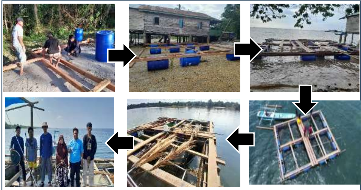
Gambar 3. Pembuatan konstruksi keramba jaring apung
