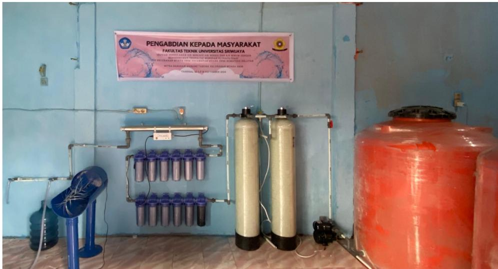
Gambar 3. Rangkaian alat pengolahan air berteknologi membran ultrafiltrasi
