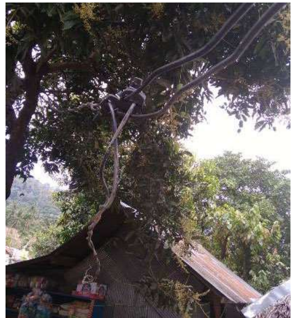
Gambar 8. Sambungan kabel twist untuk relokasi kWh meter.
