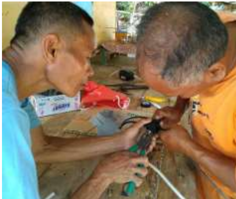
a. Praktek penyambungan kabel twist.
