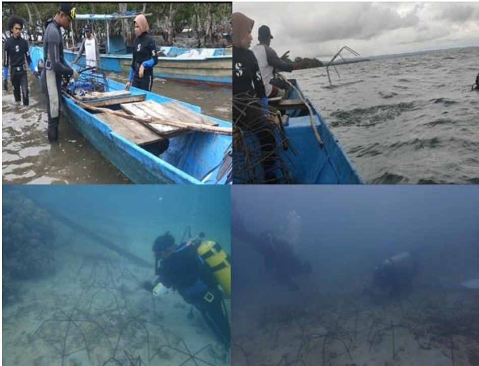
Gambar 5. Persiapan Penurunan, Penyusunan Rangka Web Spider di Laut
