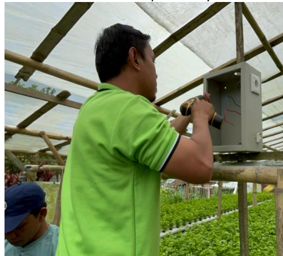
d. Pemasangan box komponen
