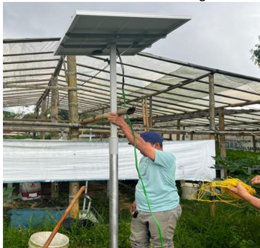
c. Pemasangan panel surya
