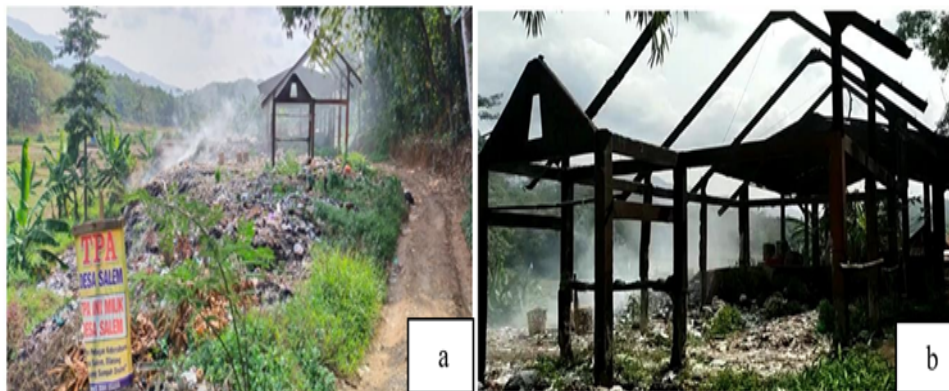
Gambar 1. (a) Tempat Pembuangan Akhir (TPA) dan (b) hanggar sampah yang terbakar
