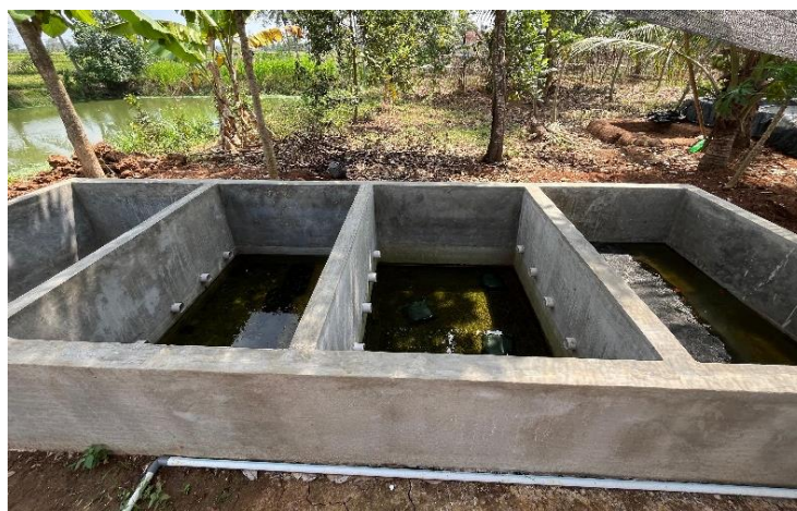
Gambar 7. Desain filter teknologi Recirculating Aquaculture System (RAS) yang digunakan
