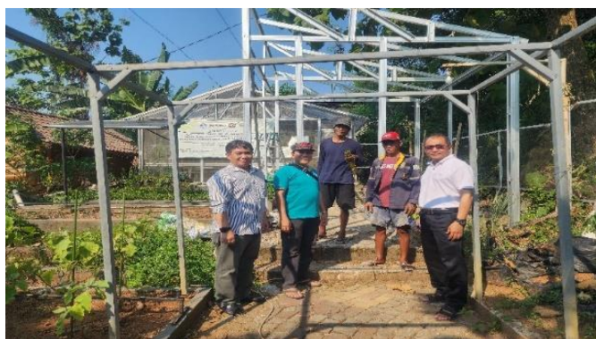
Gambar 6. Tim PKM bersma Tukang dalam Proses Pembangunan Greenhouse Hidroponik Tenaga Surya, Jul 2024
