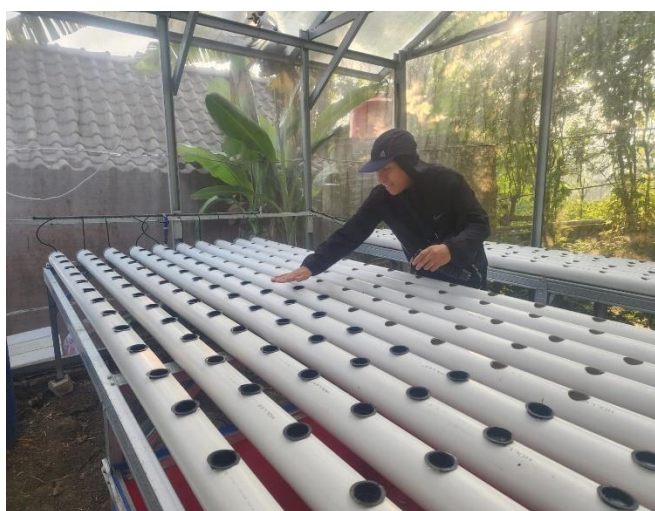
Gambar 7. Piipa-pipa hidroponik Tenaga Surya terpasang pada Greenhouse, Juli 2024
