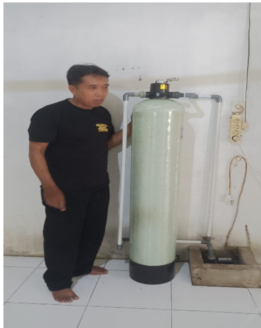
Gambar 3. Tabung filter yang sudah terpasang secara lengkap
