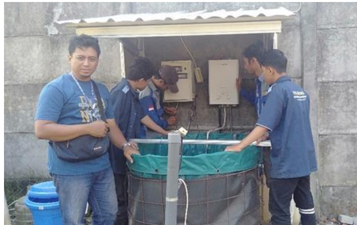
Gambar 10. Pemasangan smart pond
