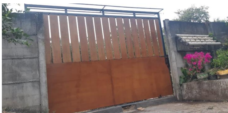
Gambar 13. Pintu gerbang yang sudah terpasang di area rintisan edu wisata
