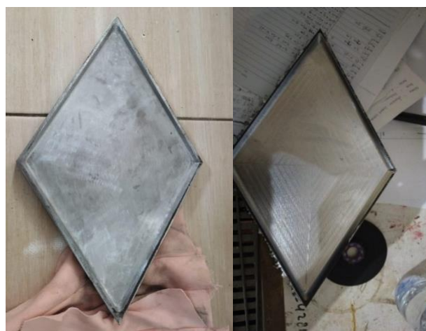
Gambar 6. Formwork yang telah jadi
