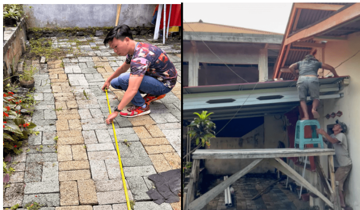
Gambar 6. Proses pengukuran dan pemasangan kanopi di area taman bermain anak
