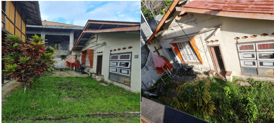
Gambar 3. Lokasi infrastruktur tempat bermain anak yang akan diperbaiki
