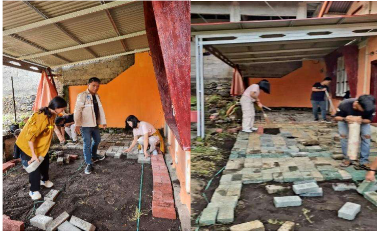
Gambar 8. Pembersihan lokasi dan pemasangan paving blok berpori
