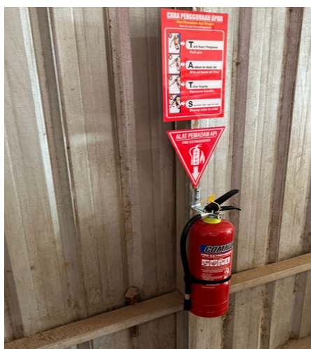
Gambar 3. Pemasangan Alat Pemadam Api Ringan (APAR)
