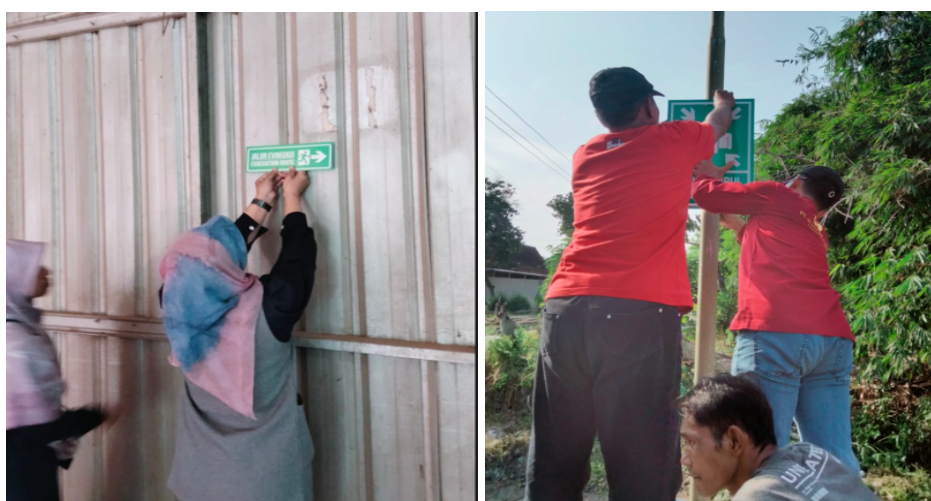
Gambar 5. Pemasangan Rambu Jalur Evakuasi dan Titik Kumpul Bencana
