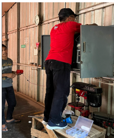
Gambar 1. Pemasangan Alarm Kebakaran
